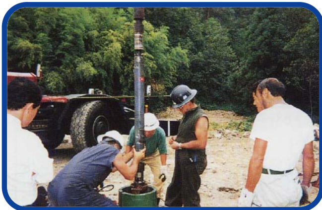
[ESPポンプ設置]
